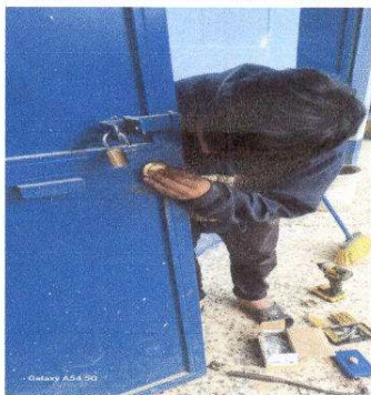
Foto1: Sustitucion de chapa
