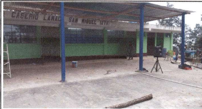
Foto 2: Pintura en muros exteriores e interiores
