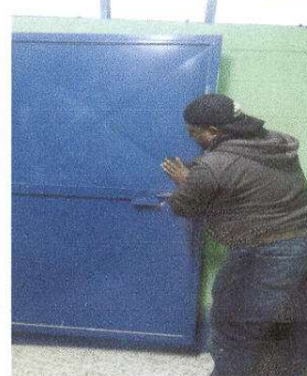
Foto 8: Mantenimiento a estructura (Lijado, cambio de tubo, cepillado, sujeciones, aplicación de pintura)
