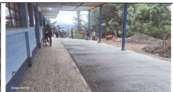
Foto 4: Reparación de planchas de concreto de patio
