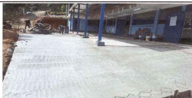
Foto 5: Reparación de planchas de concreto de patio
