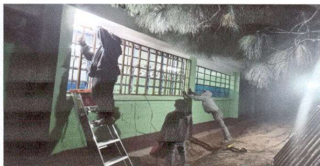
Foto 7: Fabricación e instalación de balcones de metal en ventanas
