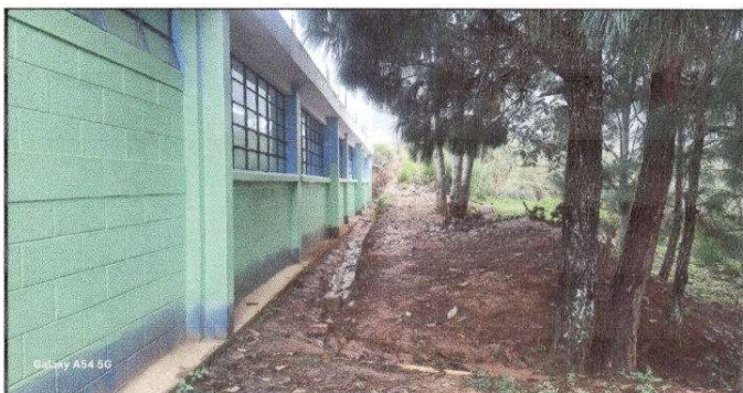
Foto 3: Pintura en muros exteriores e interiores
